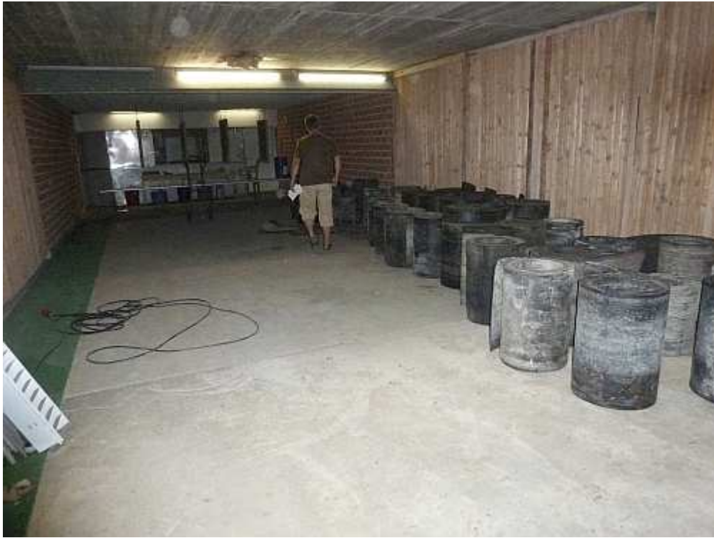
Der 25-m-Stand zu Beginn des Umbaus ...
