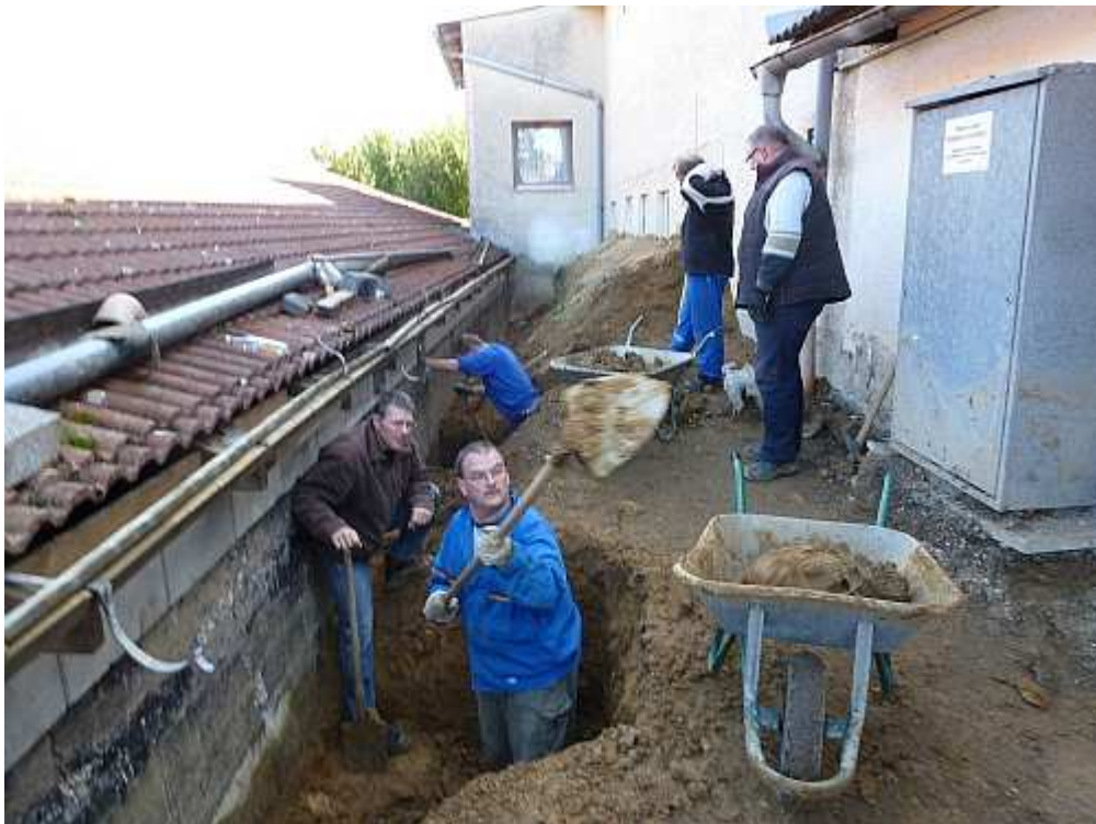
Zum Abdichten des Risses in der Außenwand musste erst einmal ausgegraben werden
