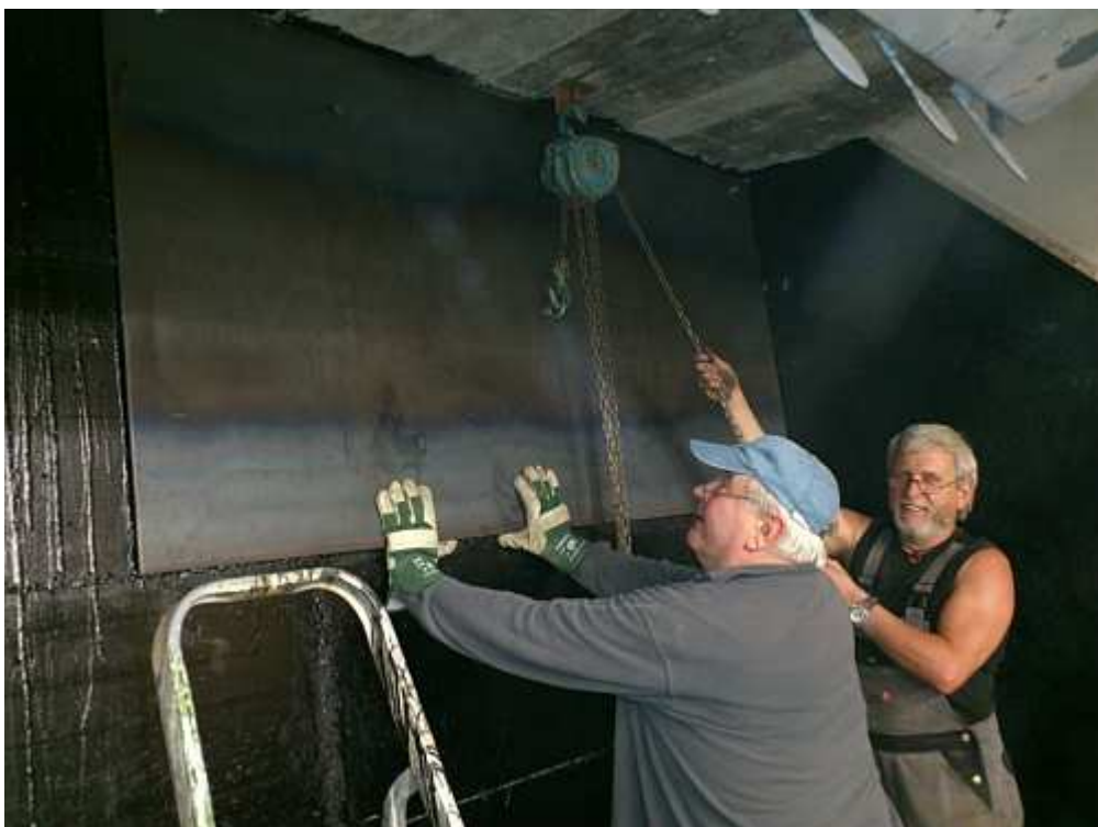
Hier wird gerade die Rückwand des neuen Kugelfangs montiert
